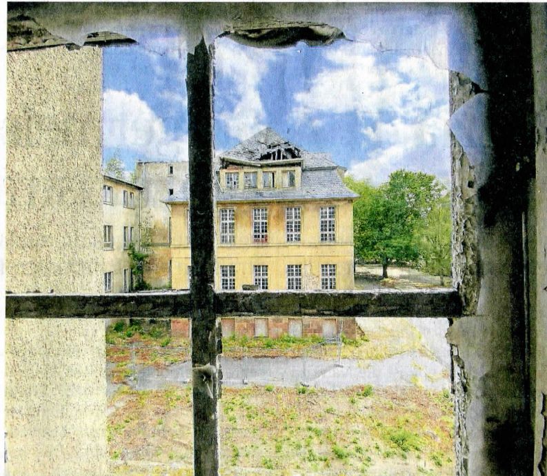
Die Dächer sind ein großer Bestandteil der Sanierungen. Aufwand und Kosten sind hoch.
